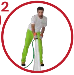
2 Puhdista kivityselue suihkuttamalla
