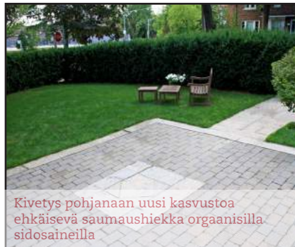
Kivitys perinteisin alusmateriaalein +3 vuoden jälkeen
