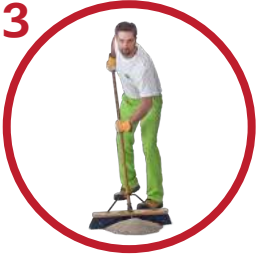
3 Lisää hiekkaa vajonneisiin saumoihin ja harjaa pinta
